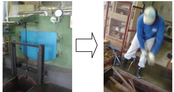
製材所でもらった背板を半分に切り、手でくべていく。(釜へは機械で) このため一人専属で職員がつき火の管理
