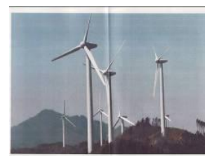
(津野町の電気をつくる風車)
