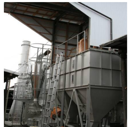
バイオマスボイラー導入
