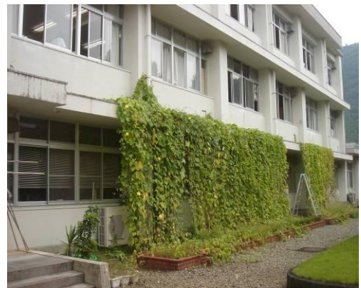
1階の職員室の窓の外側
