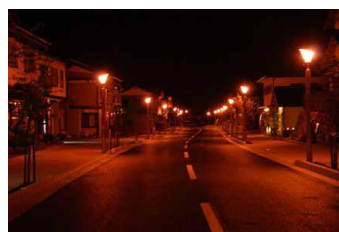
小水力発電を活用した夜間照明
